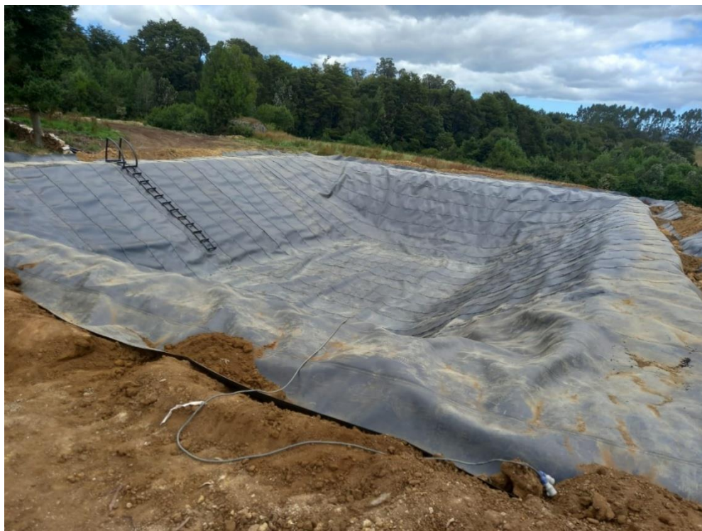
Instalación de geomembrana de HDPE para pozo rectangular.
