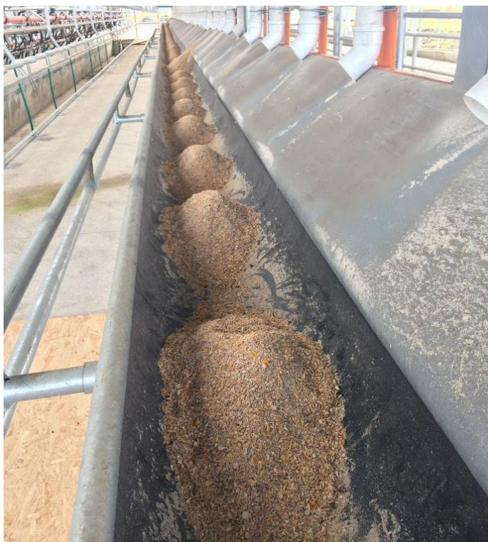
Comederos elaborados con geomembranas de HDPE recuperado.
