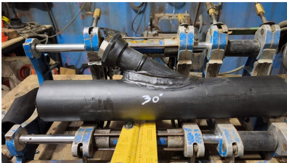
Fabricación de conexiones especiales.
