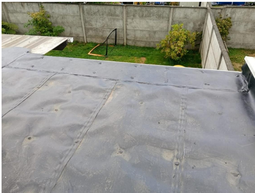
Instalación de geomembrana de HDPE para impermeabilización de techos.
